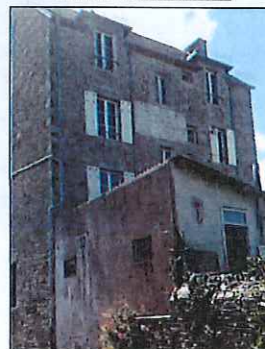
Façade arrière du bâti
